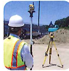
緑が見えたら右へ 測設ライン 赤が見えたら左へ
