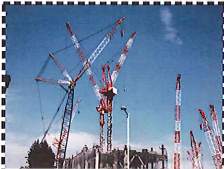
クレーン作業現場
