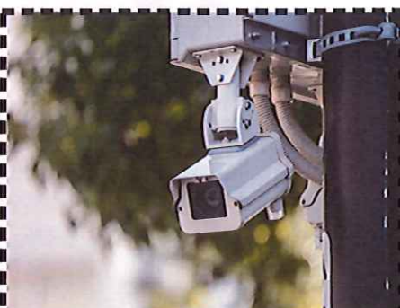
防犯カメラ設置工事
